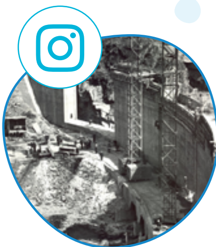
LAS OBRAS DE EL ATAZAR
